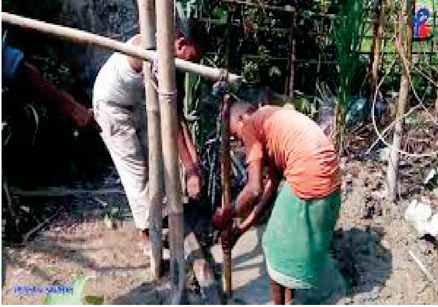
চিত্র ২২: হস্তচালিত পাম্প নলকূপ নির্মাণ কাজ
