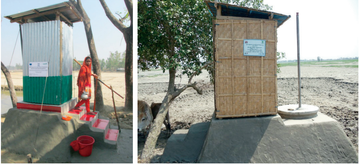
চিত্র ৪৮: রেইজড (বাম) ডাইরেক্ট সিঙ্গেল পিট ল্যাট্রিন, (ডান) অফসেট সিঙ্গেল পিট ল্যাট্রিন
