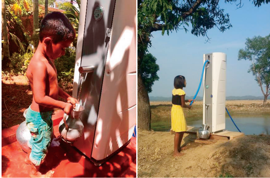
চিত্র ১৫: স্বয়ংক্রিয় আল্ট্রা ফিল্ট্রেশন (বাম) এবং হস্তচালিত আল্ট্রা ফিল্ট্রেশন (ডান)
