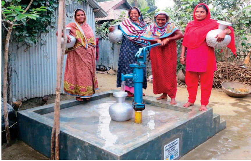
চিত্র ১৯: ডিপ-সেট নলকূপ (কৃতজ্ঞতায়: কনসার্ন ওয়ার্ল্ডওয়াইড)
