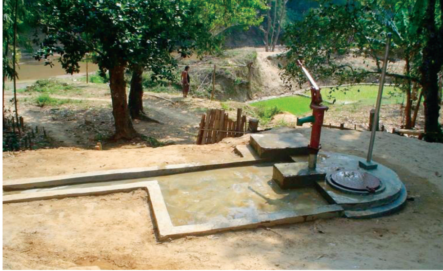
চিত্র ২৩: পানি সরবরাহের জন্য টিউবওয়েলসহ সুরক্ষিত পাতকূয়া (কৃতজ্ঞতায়: ওয়াটারএইড বাংলাদেশ)
