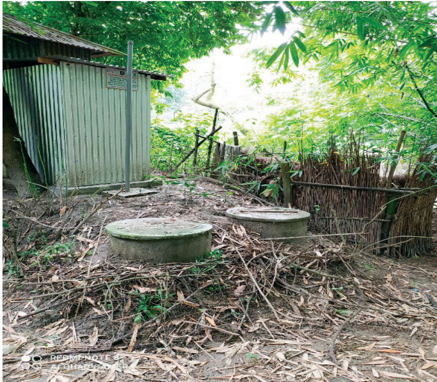
চিত্র ৪৯: রেইজড টুইন পিট ল্যাট্রিন
