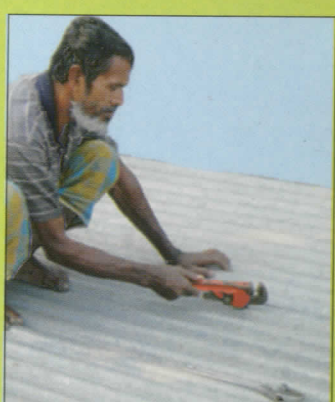
২৯. ফিল্টার বেডের ঢালা ঠিক আছে কিনা, না থাকলে মেরামত করতে হবে। এরপর পাম্প করে পি এস এফ টি চালু করতে হবে।
