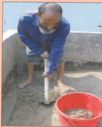
৯. ফিল্টার বেড হতে বালুর উপরিভাগ থেকে ০' - ৬" পরিমাণ বালু তুলে ফেলতে হবে এবং নতুন করে সমপরিমাণ বালু দিয়ে পূর্ণ করে দিতে হবে।
